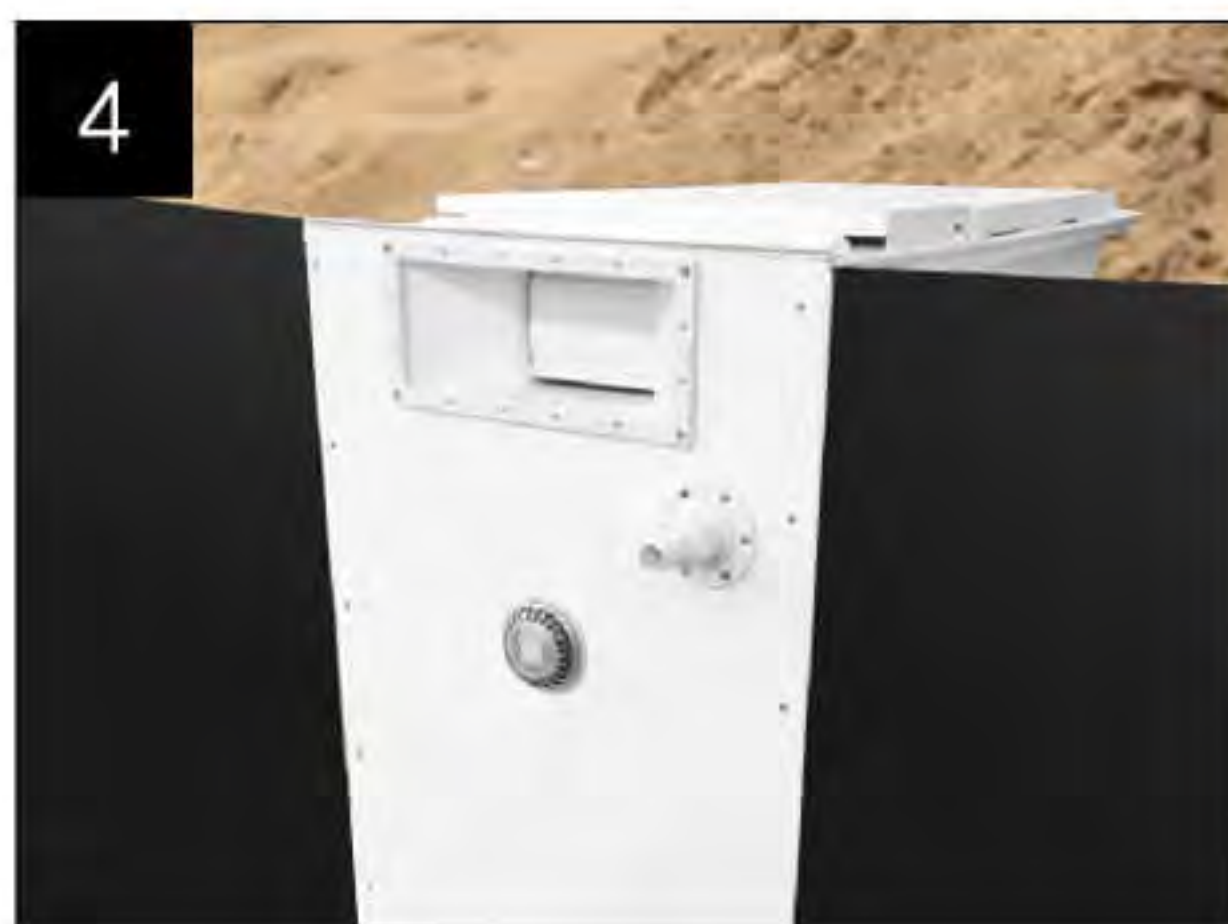
4 TE Filter Installation ติดตั้งเครื่องกรองอัจฉริยะ
