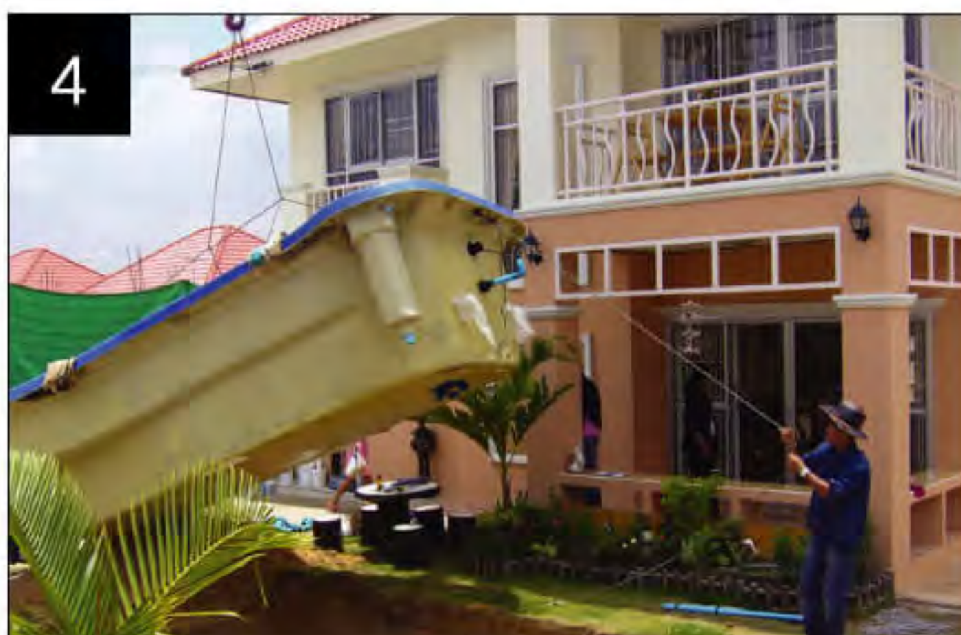
4 The Pool is lowered into the hole การวางสระ
