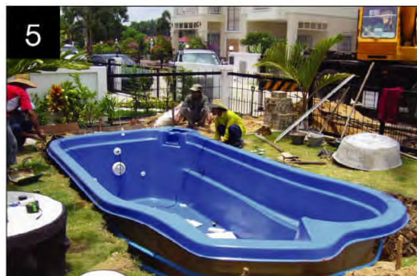
5 Filtration, Plumbing and Light installation การติดตั้งอุปกรณ์งานระบบกรอง และงานไฟฟ้า
