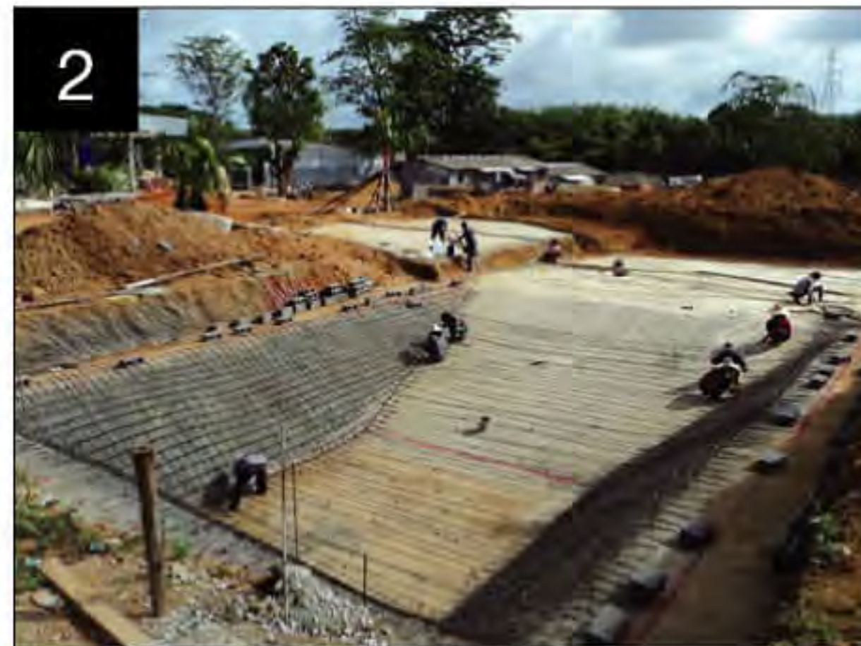
2 Reinforced Rebar Slab and Levelling Blocks เทเส้นพื้นสระ และวางเหล็กเส้น
