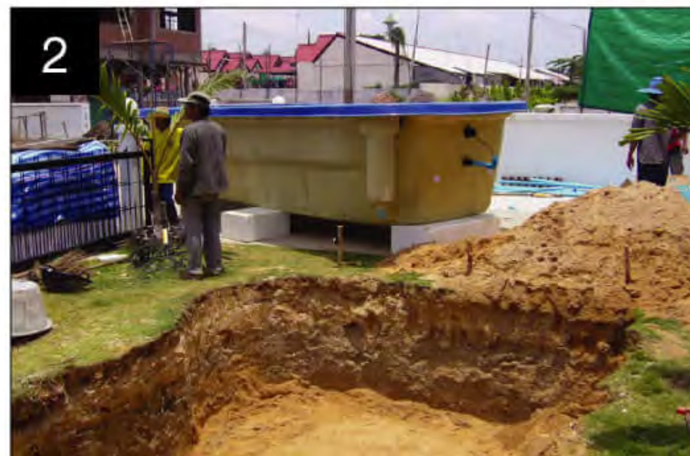
2 Ground Preparation and Excavation ขุดดินเตรียมพื้นที่ลงสระ
