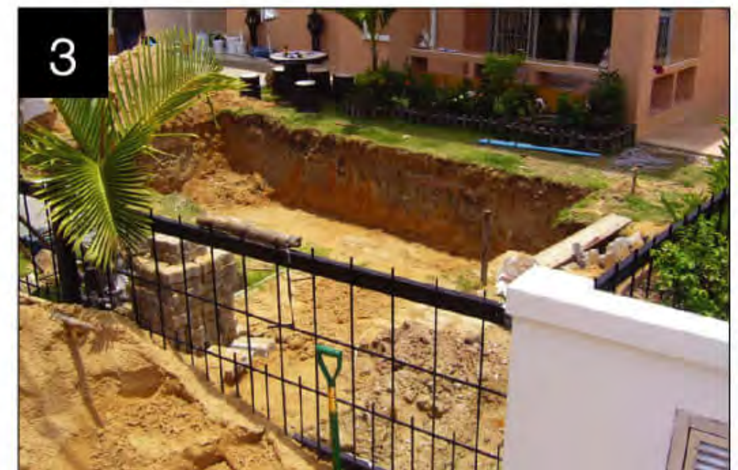
3 Hole Surface Preparation and Sand Bed การเตรียมหน้าดิน การปรับระดับ
