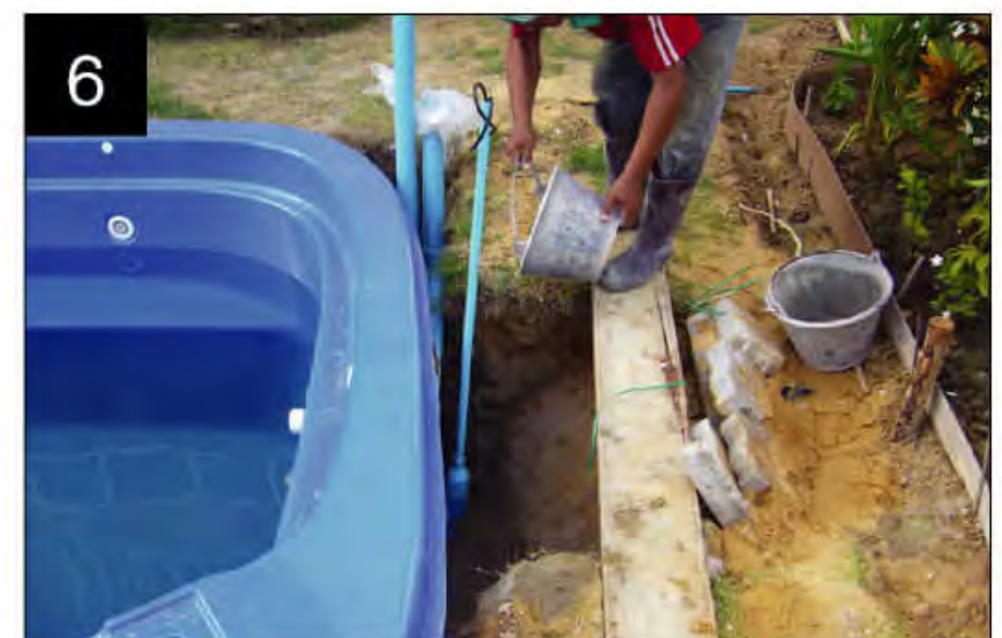
6 Begin filling with water and back filling งานกมยี่ระดับสระ
