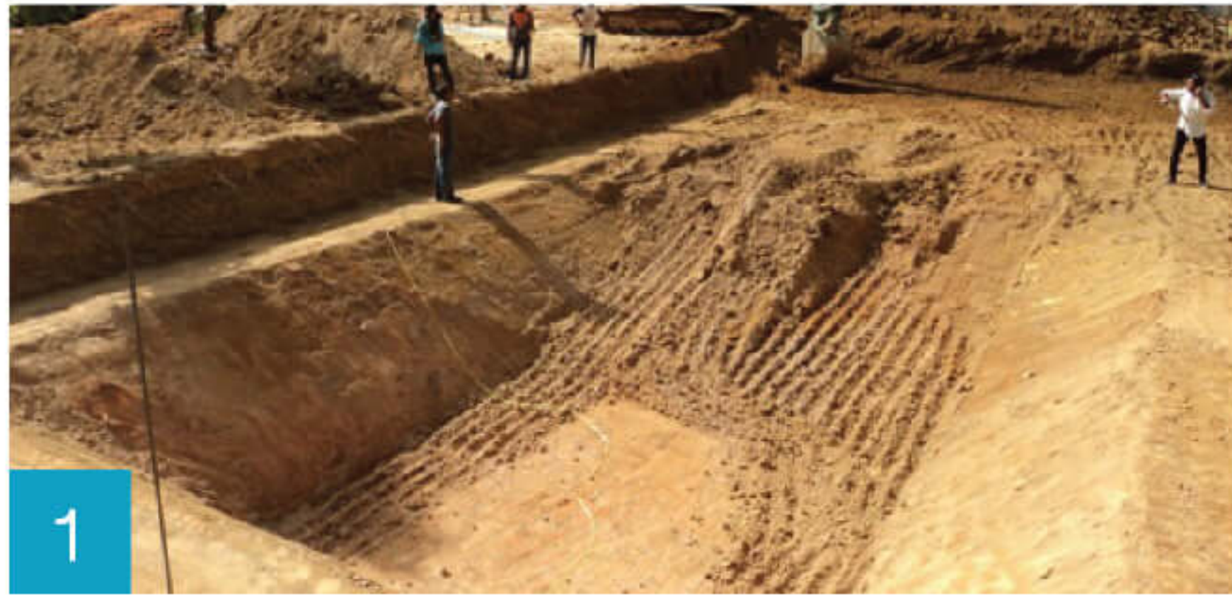
1 Layout and Excavation วางผังและขุดดิน
