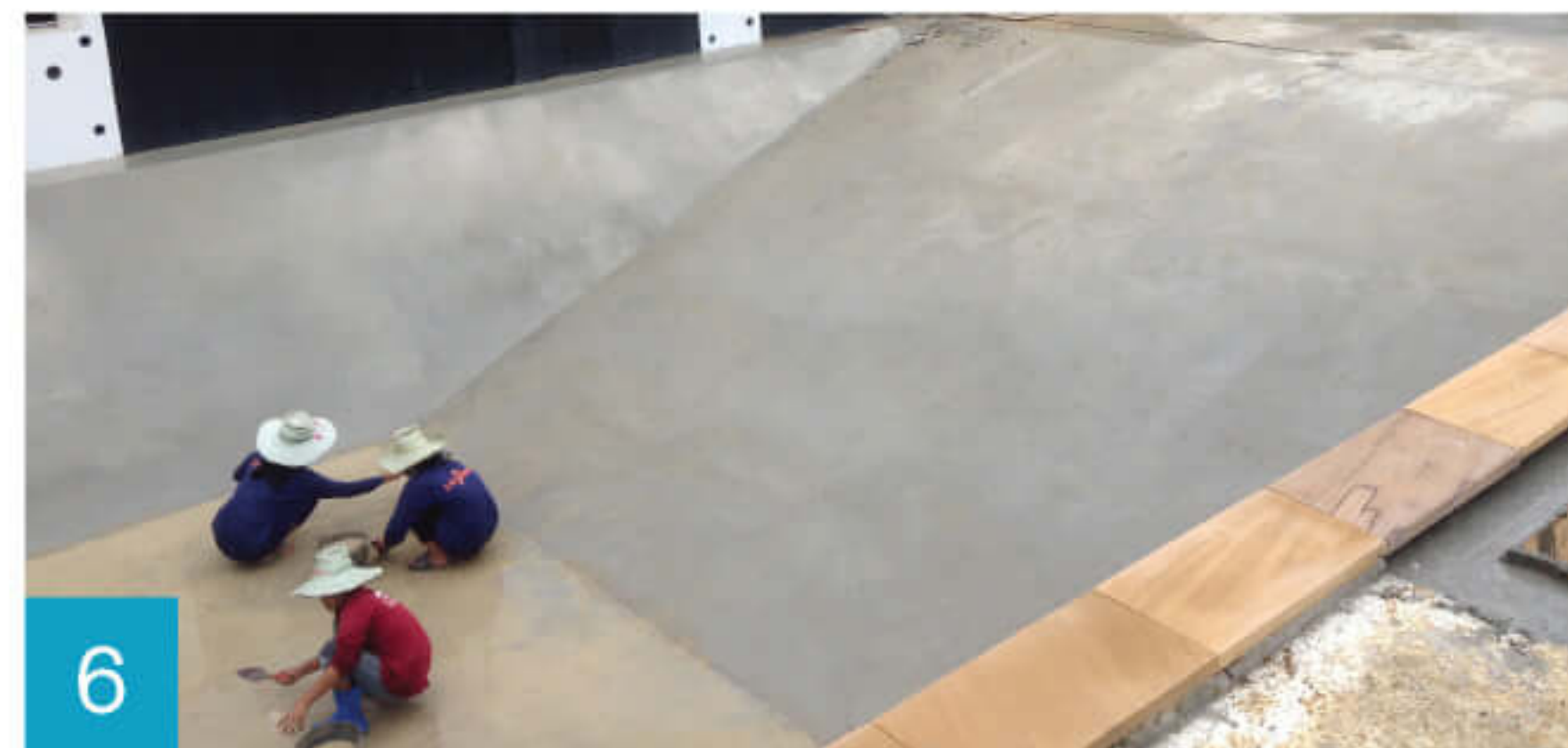
6 Laying coping stones and then ready for PVC lining วางหินทรายขอบสระ และเตรียมงานไลเนอร์
