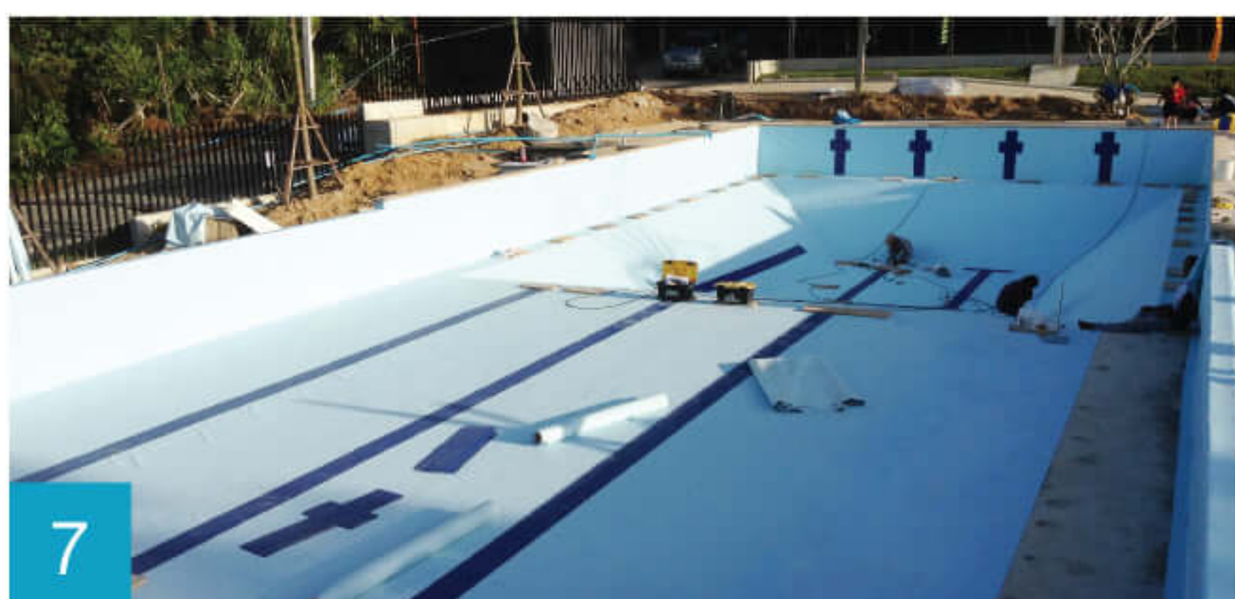
7 PVC lining complete ติดตั้งไลเนอร์ผนัง พื้น
