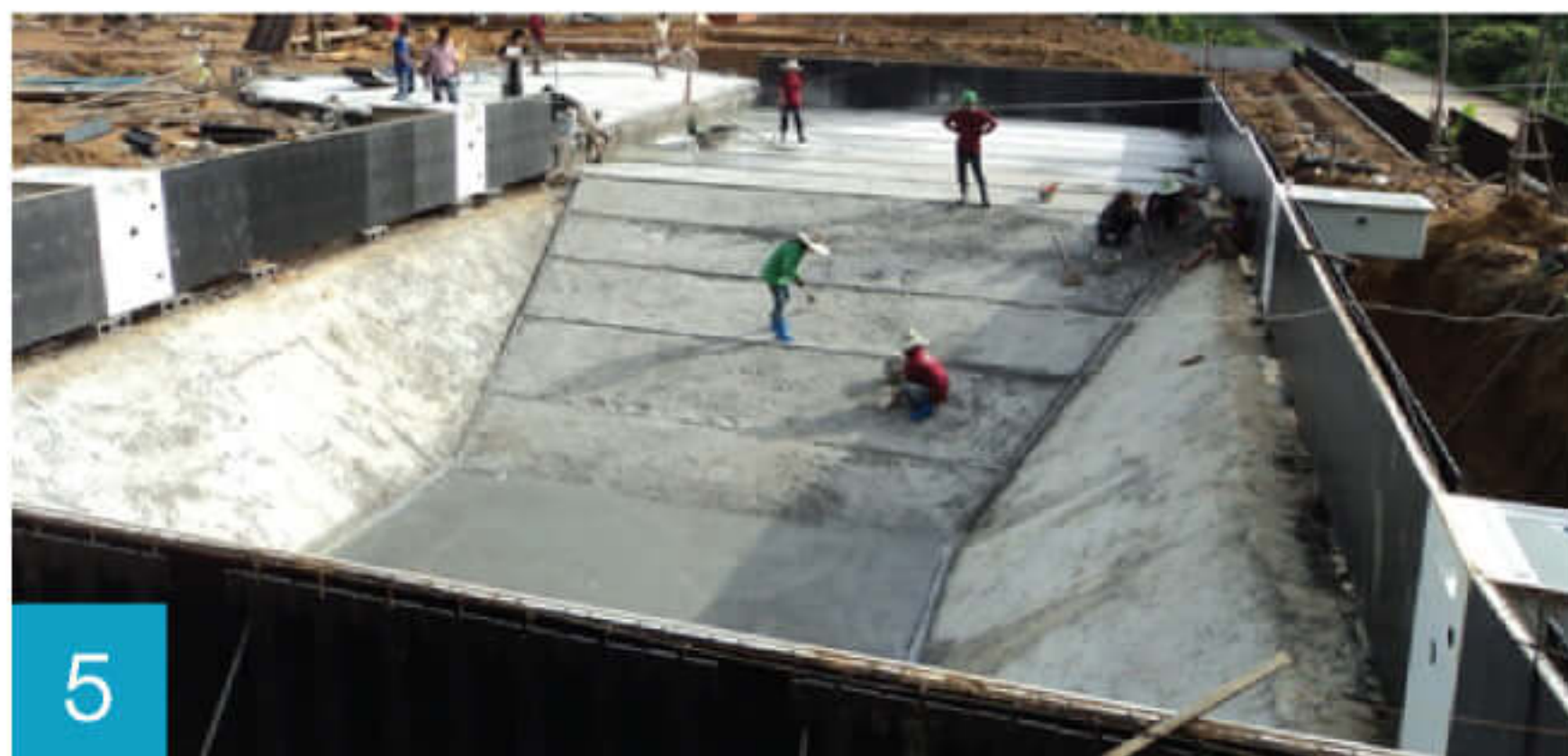
5 Pours concrete into pool slab and wall in a single process เทคอนกรีตและผนัง พร้อมกันเป็นงานชิ้นเดียว
