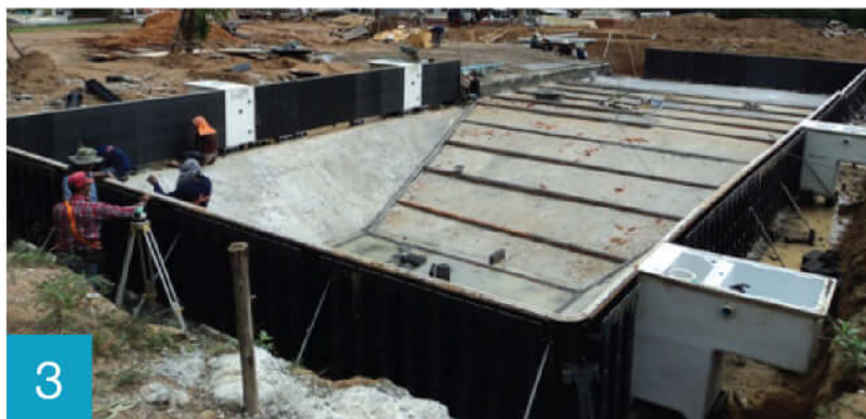
3 Assembly of Permanent iPanel เตรียมผนังสำเร็จตามแบบ และตั้งผนัง
