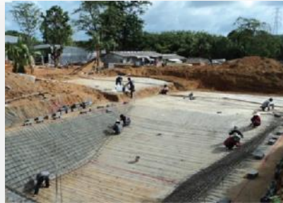
2. เทลีนพื้นสระ และวาง เหล็กเส้น
