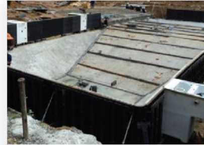
3. เตรียมผนังสำเร็จตาม แบบ และตั้งผนัง
