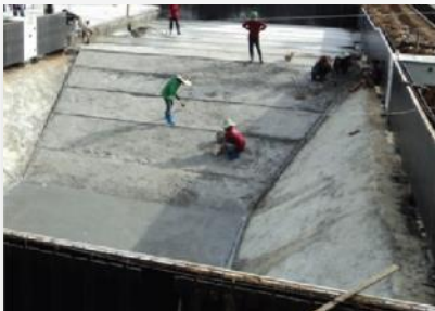
5. เทคอนกรีตพื้นและผนัง พร้อมกันเป็นงานชิ้นเดียว
