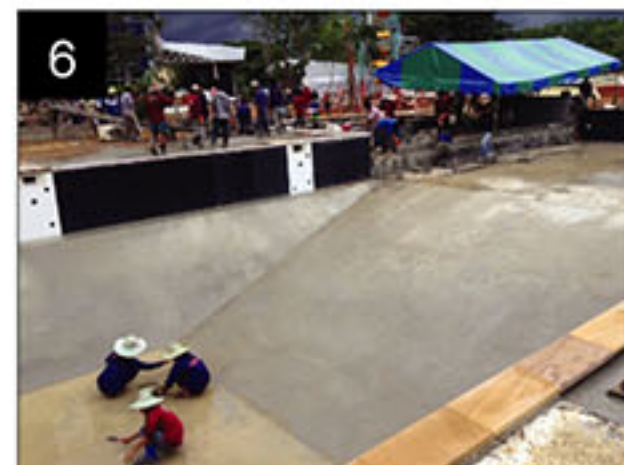
Laying coping stones and then ready for PVC lining วางหินทรายขอบสระ และเตรียมงานไลเนอร์
