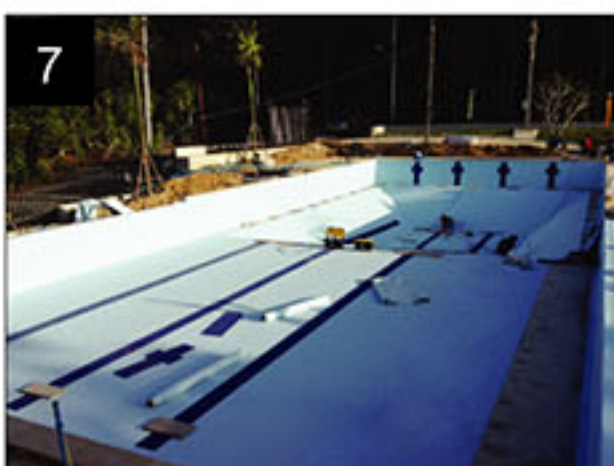
PVC lining complete ติดตั้งไลเนอร์ผนัง พื้น
