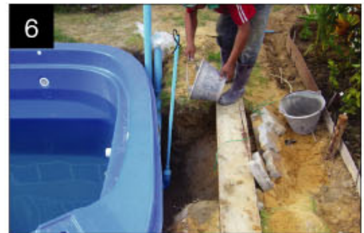
Begin filling with water and back filling งานกบยี้ระดับสระ
