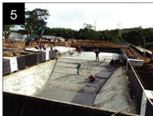
Pours concrete into pool slab and wall in a single process เทคอนกรีตและผนัง พร้อมกัน เป็นงานชิ้นเดียว
