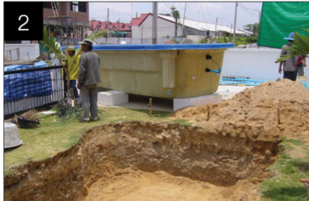
Ground Preparation and Excavation ขุดดินเตรียมพื้นที่ลงสระ
