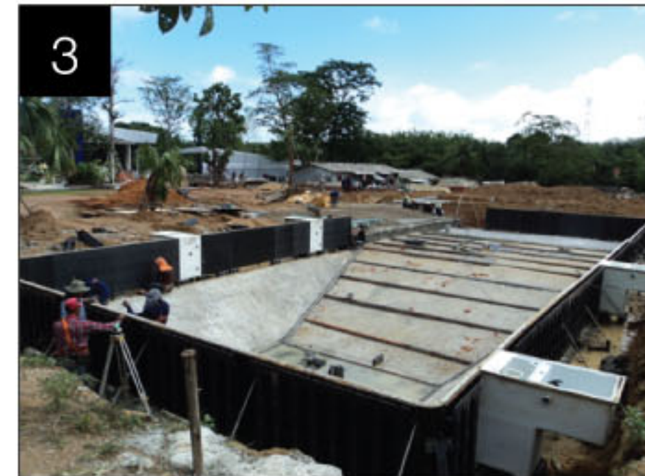
3 Assembly of Permanent iPanel เตรียมผนังสำเร็จตามแบบ และตั้งผนัง
