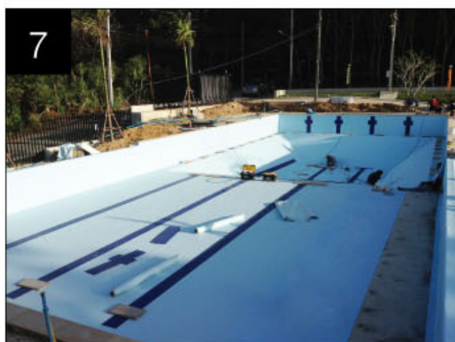
7 PVC lining complete ติดตั้งไลเนอร์ผนัง พื้น
