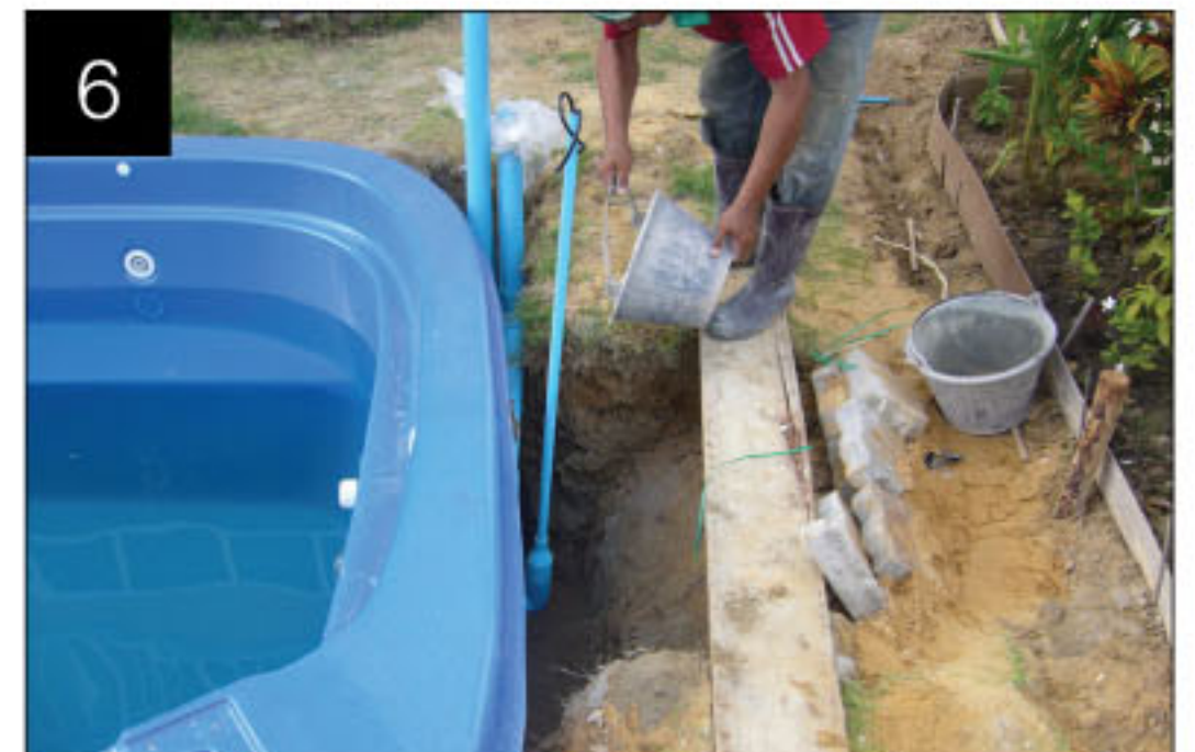
Begin filling with water and back filling งานกมยี่ระดับสระ
