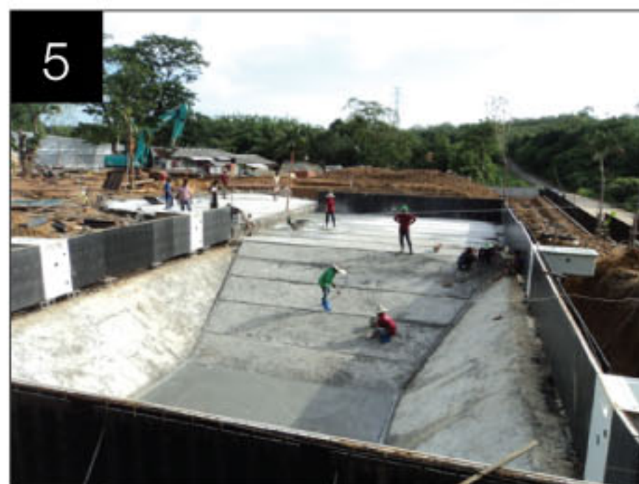
5 Pours concrete into pool slab and wall in a single process เทคอนกรีตและผนัง พร้อมกัน เป็นงานชิ้นเดียว
