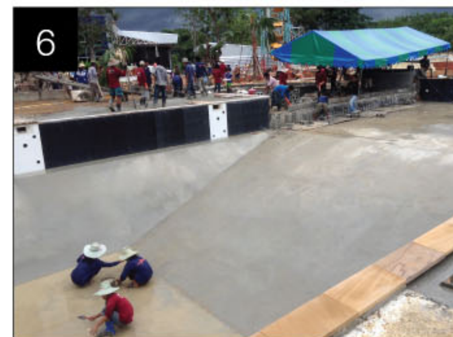
6 Laying coping stones and then ready for PVC lining วางหินทรายขอบสระ และเตรียมงานไลเนอร์
