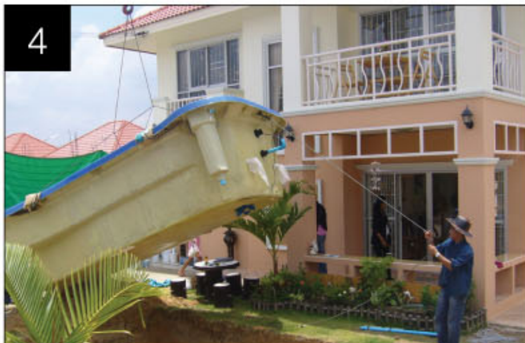
The Pool is lowered into the hole การวางสระ
