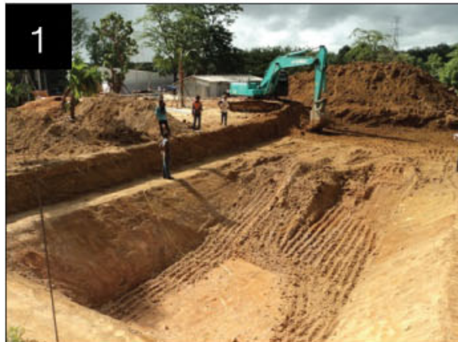
1 Layout and Excavation วางผัง และขุดดิน
