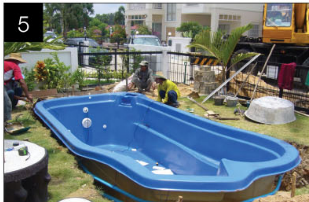
Filtration, Plumbing and Light installation การติดตั้งอุปกรณ์งานระบบกรอง และงานไฟฟ้า
