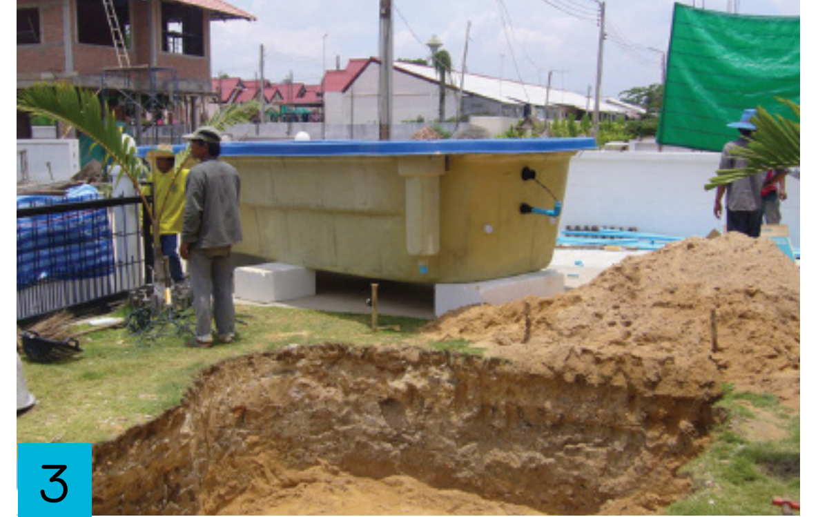
Hole Surface Preparation and Sand Bed การเตรียมหน้าดิน การปรับระดับ
