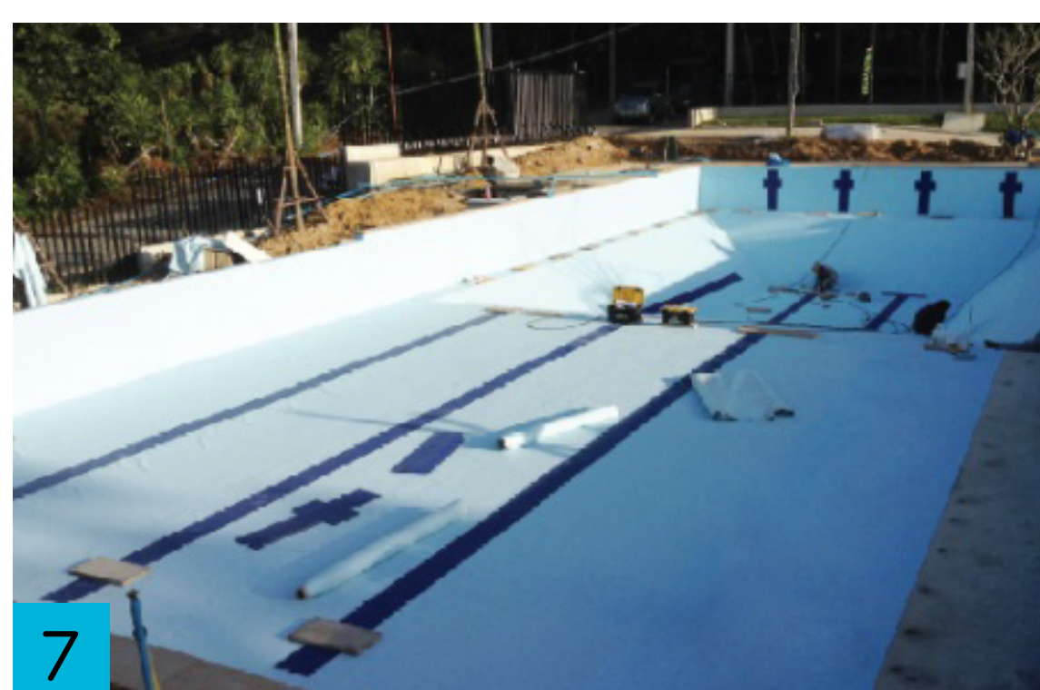
PVC lining complete ติดตั้งไลเนอร์ผนัง พื้น
