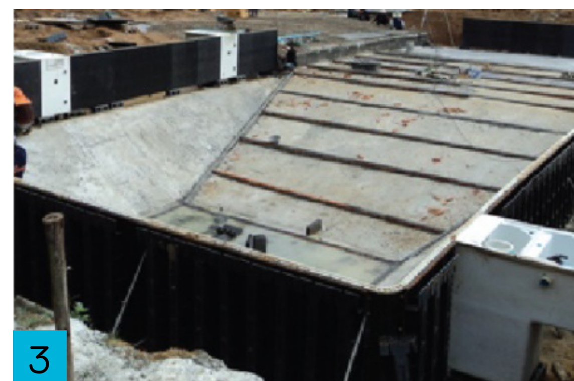
Assembly of Permanent iPanel เตรียมผนังสำเร็จตามแบบ และตั้งผนัง
