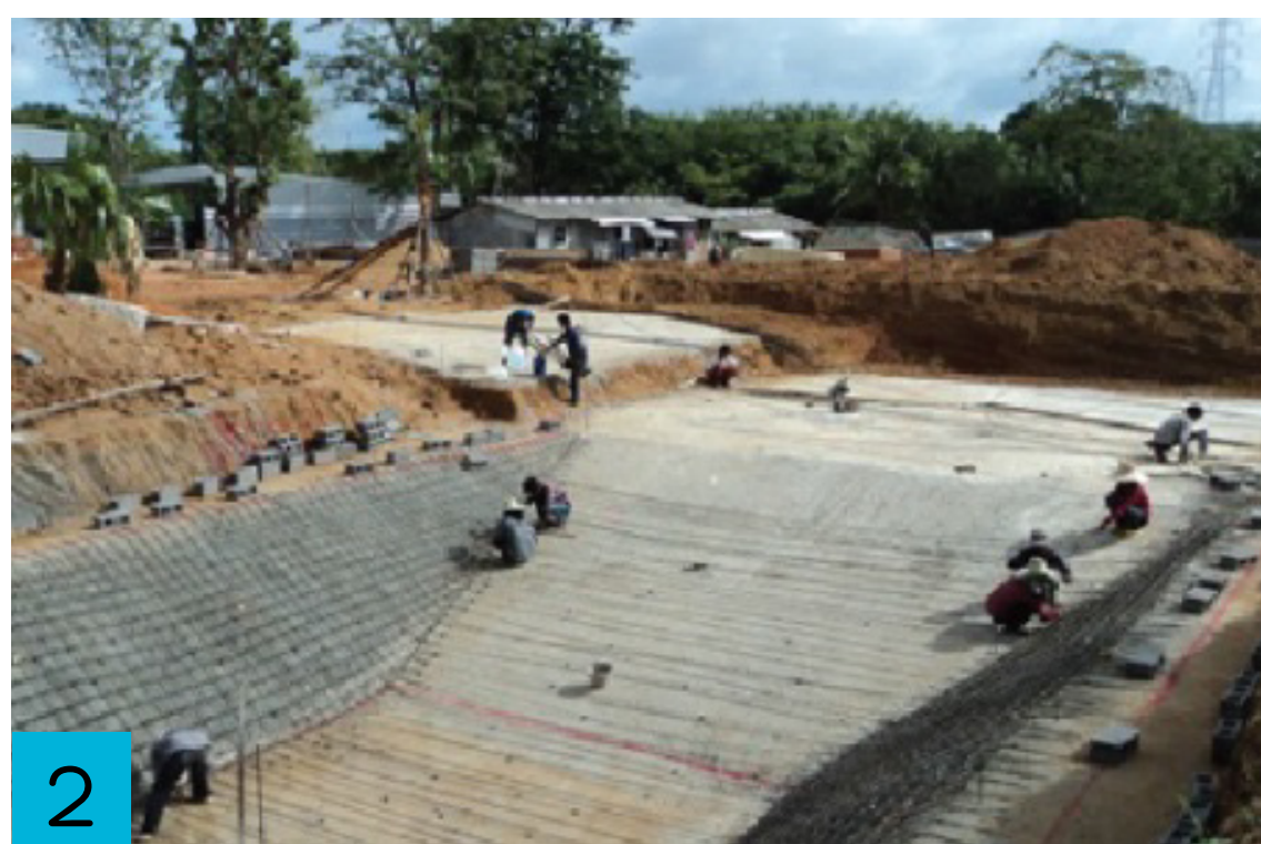
Reinforced Rebar Slab and Levelling Blocks เทเส้นพื้นสระ และวางเหล็กเส้น
