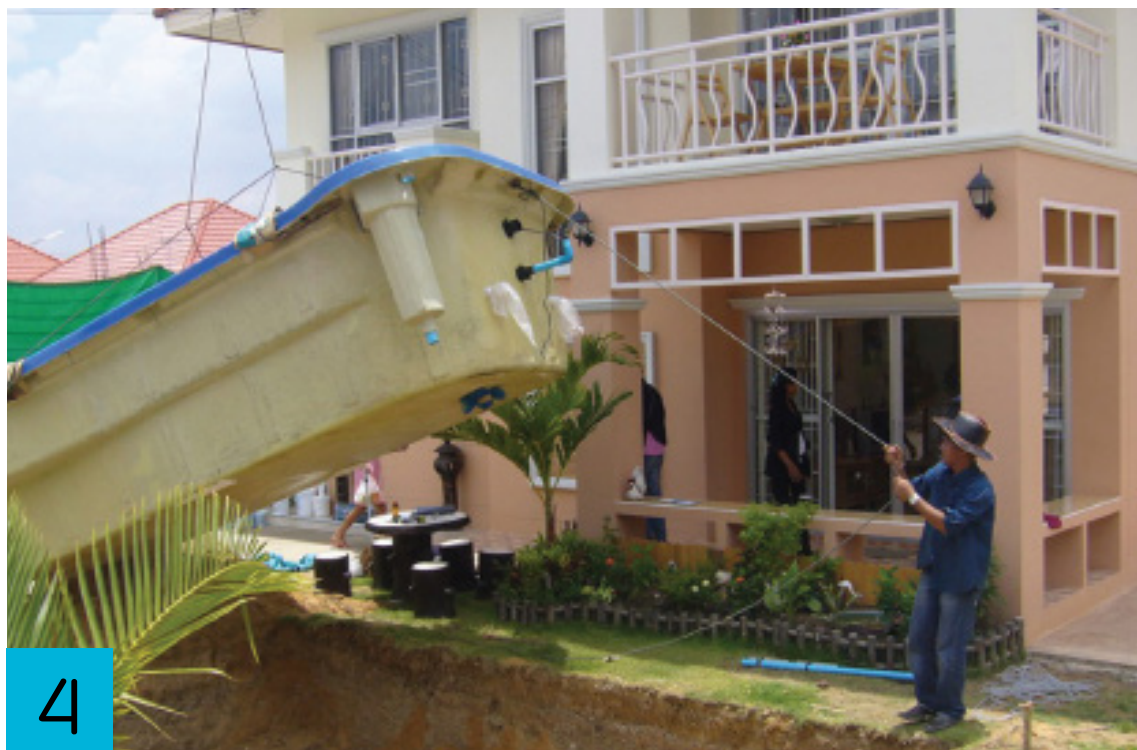
The Pool is lowered into the hole การวางสระ
