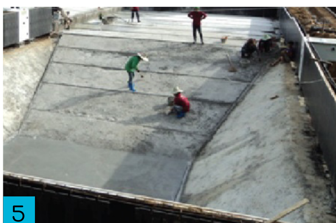
Pours concrete into pool slab and wall in a single process เทคอนกรีตและผนัง พร้อมกันเป็นงานชิ้นเดียว
